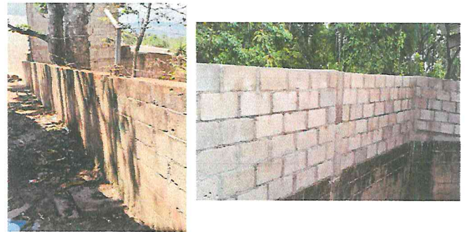
Foto 10: Levantamiento de muro perimetral.
