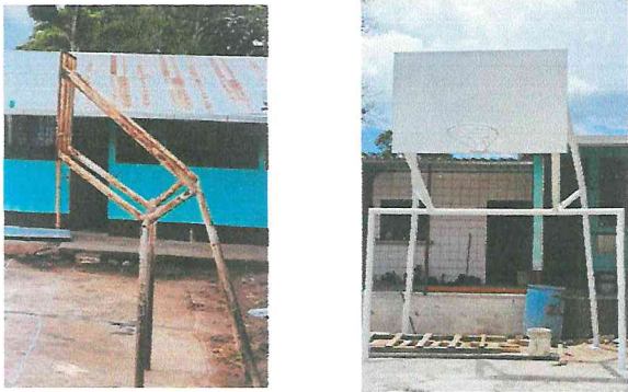
Foto 9: Mantenimiento y pintura de estructura y aros de la cancha.
