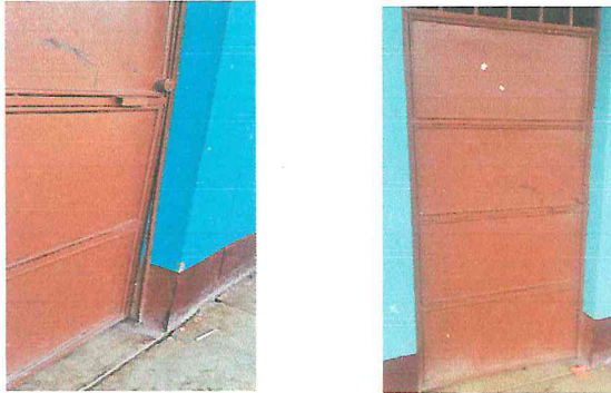
Foto7: Mantenimiento de puerta.
