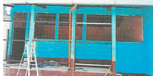
Foto 8: Colocación de malla metálica, enfrente de la cancha y la cocina.
